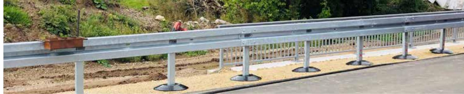
Die Zeiten für das Rammen der KOMPRI® 100 (125) Pfosten sind etwas höher als bei einem Standardpfosten.
